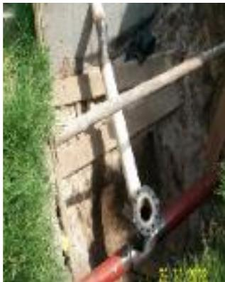
Accesorio hot tap de sacrificio, ver tubería y caja de inspección.
