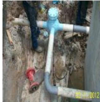
Sistema con hot tap esferica de sacrificio. Ver caja de inspección donde quedará la válvula.
